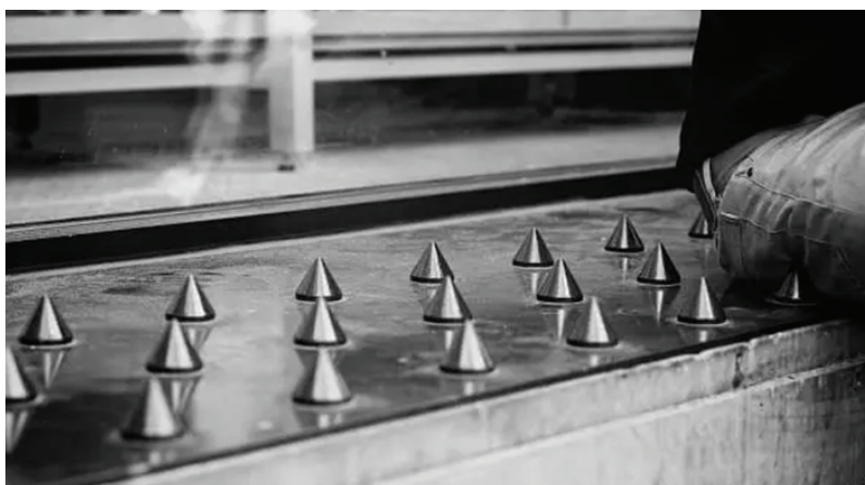
Figura 2 – Pontas de metal instaladas em beirais de vitrines e janelas, para impedir a permanência de pessoas, principalmente deitadas
