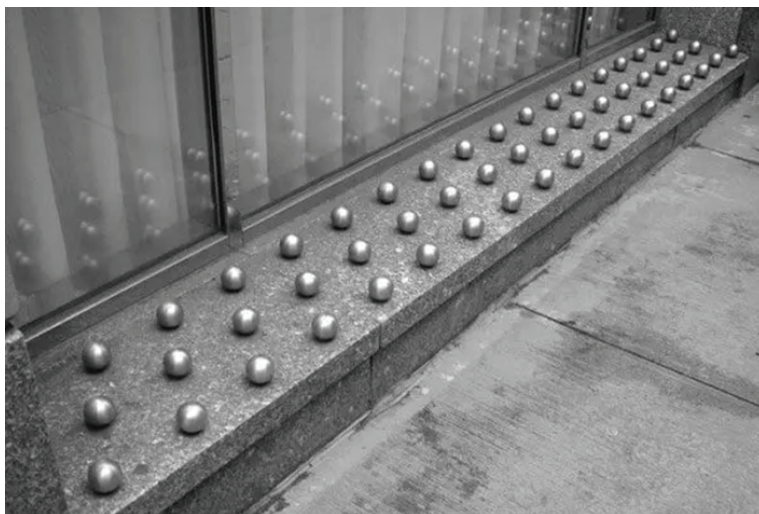
Figura 8 – Esferas de metal instaladas em beiral de vitrine, para impedir permanência de pessoas, principalmente deitadas
