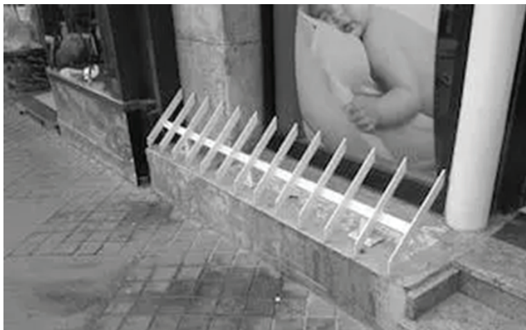
Figura 3 – Grades instaladas em projeções de edifícios, para impedir a aproximação e permanência de pessoas
