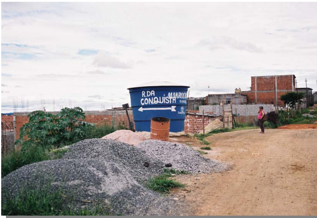
Foto 6 – Aspecto das construções no Alto Santo Antônio
